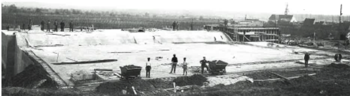
Construction du réservoir d'Ingersheim en 1932 (Archives Musées des Usines Municipales de Colmar)
