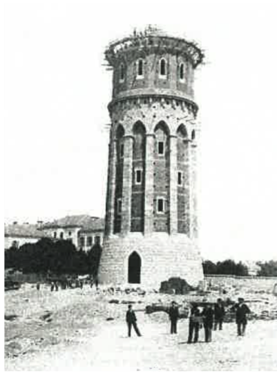
Construction du château d'eau (Archives Musées des Usines Municipales de Colmar)
