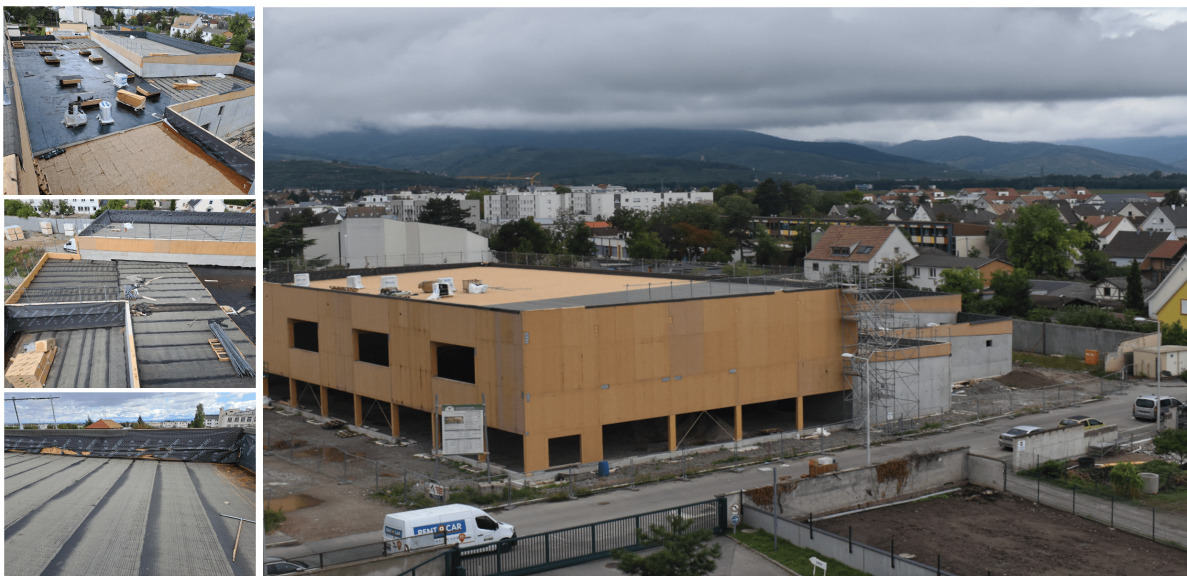
Prise de vue du 8 septembre 2024 : pose de la première couche d'étanchéité en toiture du bâtiment
