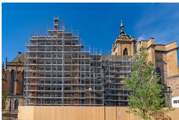
La restauration concernera des éléments comme les pierres de taille, la maçonnerie, la charpente, la ferronnerie, les balustres, la rénovation du clocheton. Le chantier passe par la nef, le transept nord, le chœur déambulatoire et les chapelles, la nef et le transept sud et se termine par le massif occidental.
