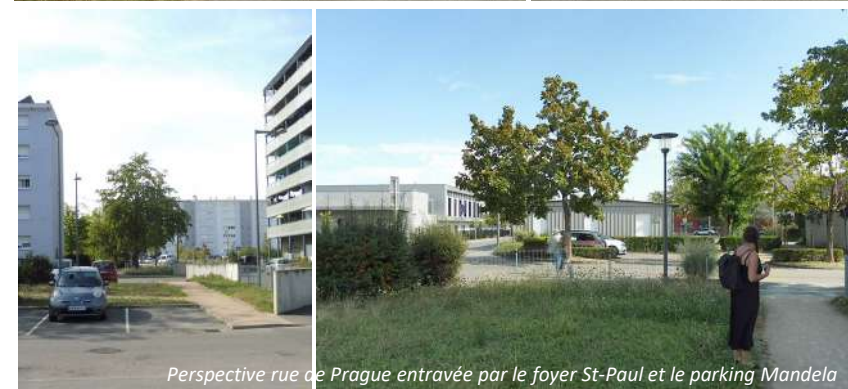
La grande promenade latérale entravée par le parking de l'espace Mandela
