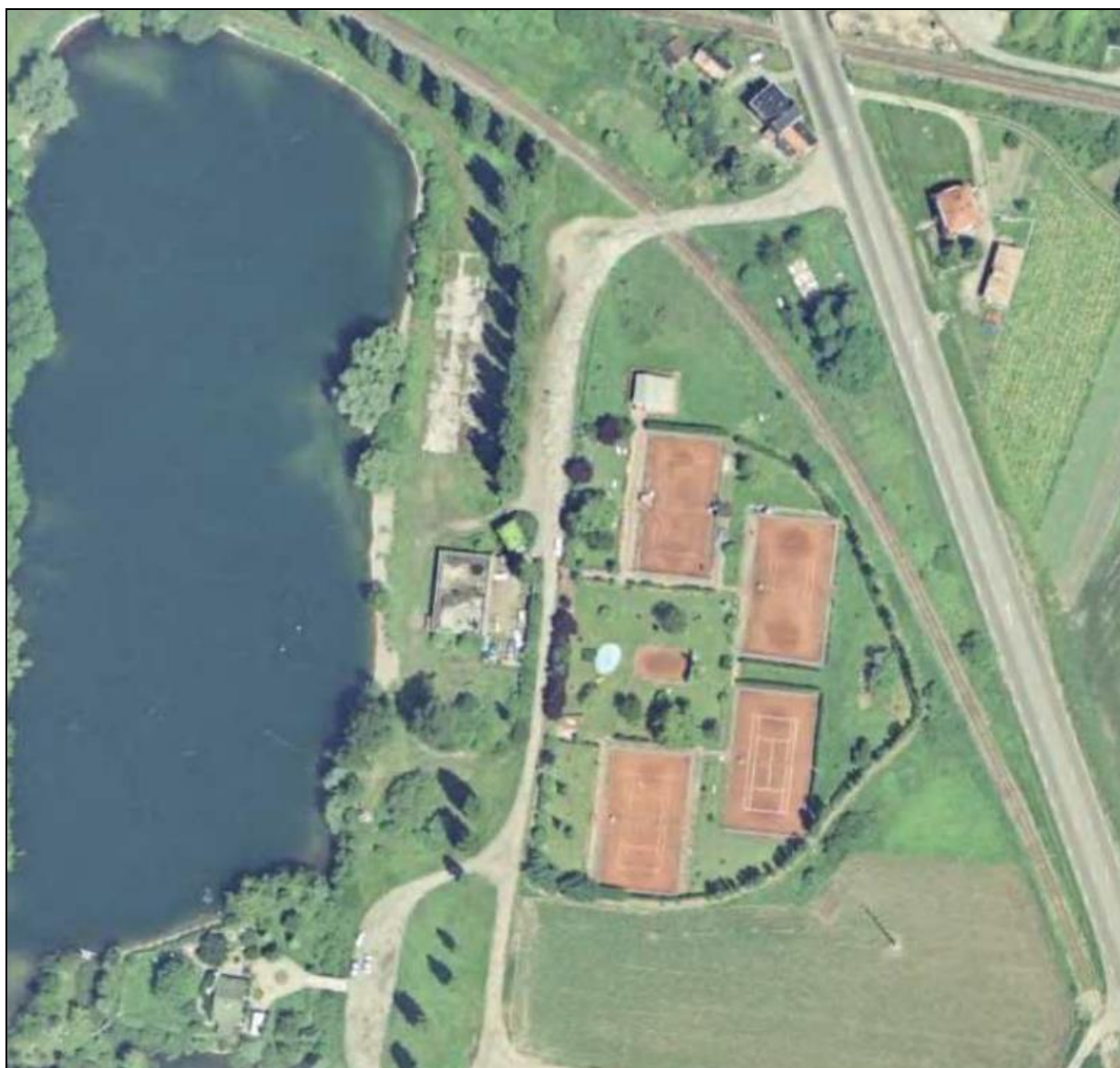
Photographie aérienne du site de 1981
