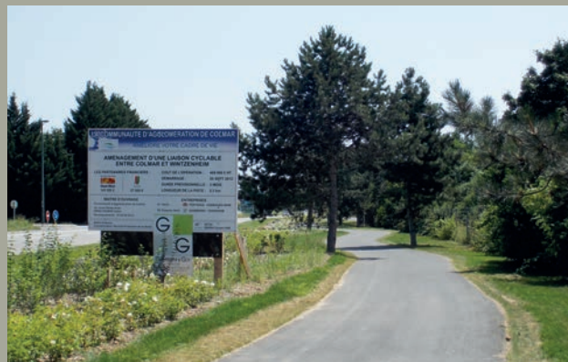
Liaison cyclable Colmar/Wintzenheim : 1er tronçon
