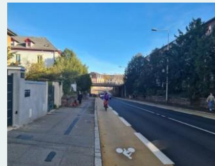
Des bandes cyclables de 1 m 50 de largeur, revêtues d'une teinte ocre ont été aménagées au niveau du pont de la route d'Ingersheim - DNA 2022
