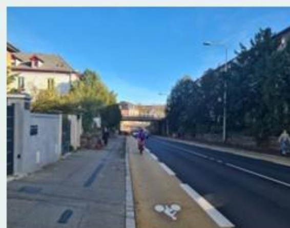
Des bandes cyclables de 1 m 50 de largeur, revêtues d'une teinte ocre ont été aménagées au niveau du pont de la route d'Ingersheim – DNA 2022
