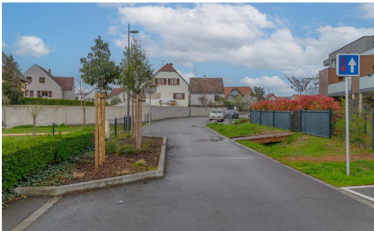
Réaménagement de l'ouvrage d'art de traversée d'un fossé, avec une voie apaisée, longée par une noue végétalisée d'un côté et une chicane avec un sens de priorité de l'autre. Sept places de stationnement ont également été créées. L'éclairage public a été renouvelé et les câbles téléphoniques aériens ont été enfouis.
