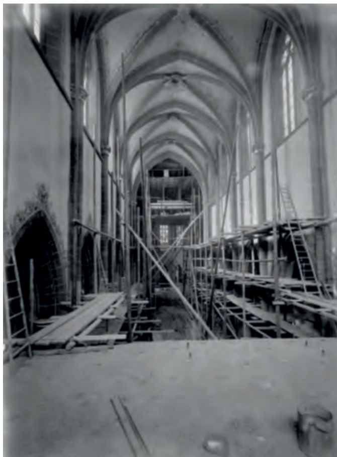
L'intérieur de la Cathédrale Saint-Martin pendant les travaux 1901-1911
