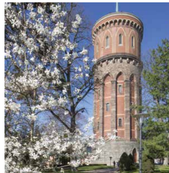
La tour de l'ancien château d'eau construit en 1884-1886.
